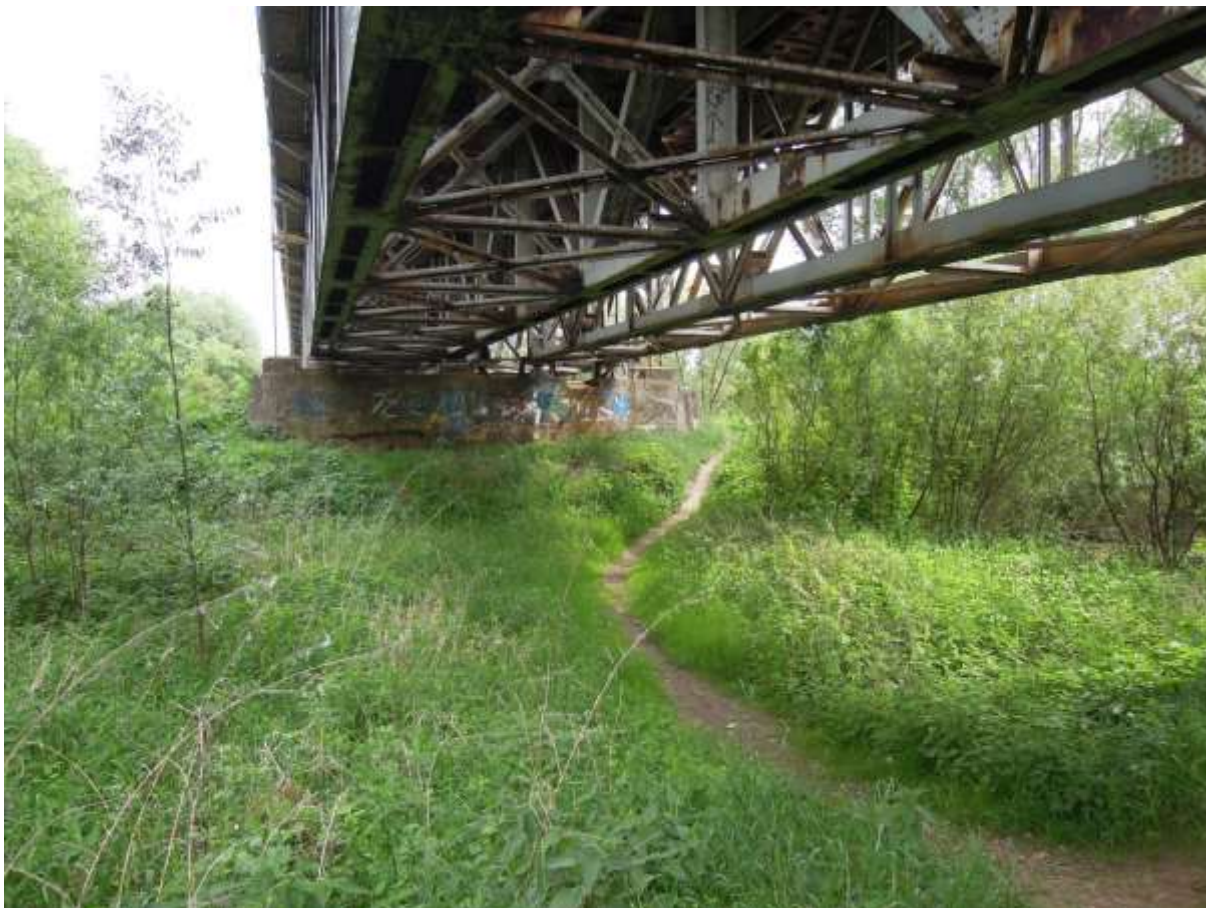
Rysunek 32. Koniec trasy rowerowej pod stalowym mostem kolejowym
