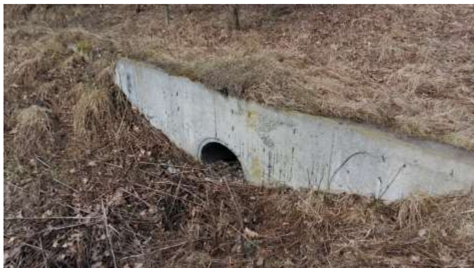
Rysunek 19. Wylot przepustu poniżej ul. Kościelniaka w Mysłowicach
