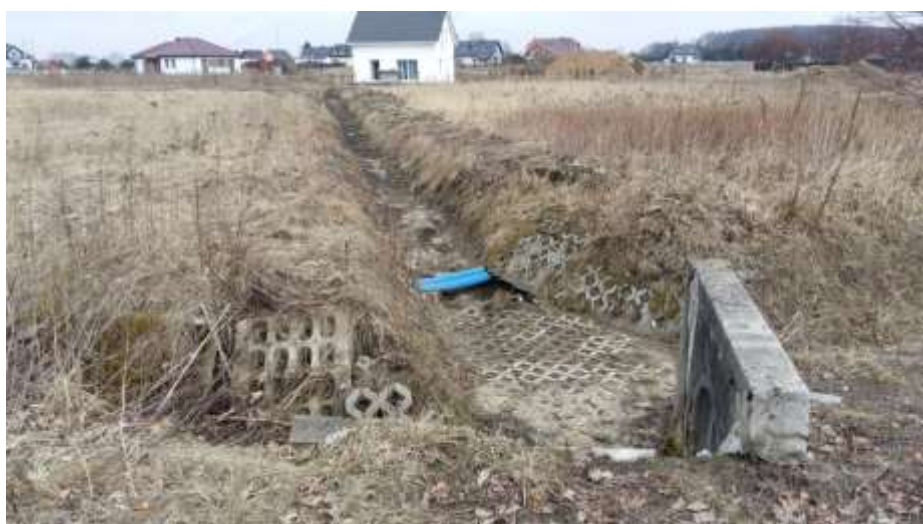
Rysunek 20. Częściowo odtworzone rowy i wlot przepustu powyżej ul. Kościelniaka w Mysłowicach
