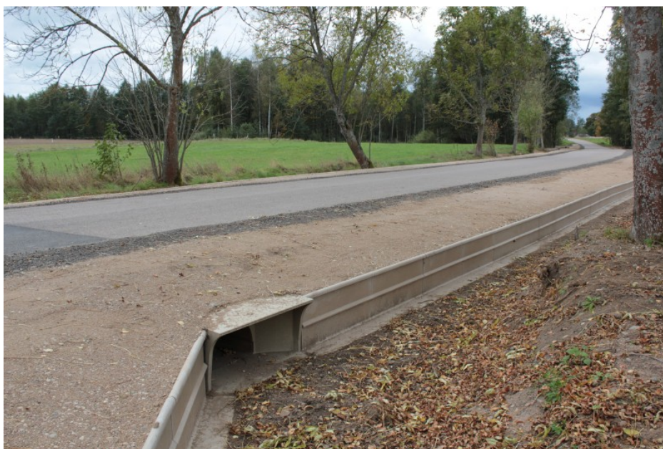
Rysunek 32. Wariant realizacji przejścia dla płazów w ścieżce rowerowej
