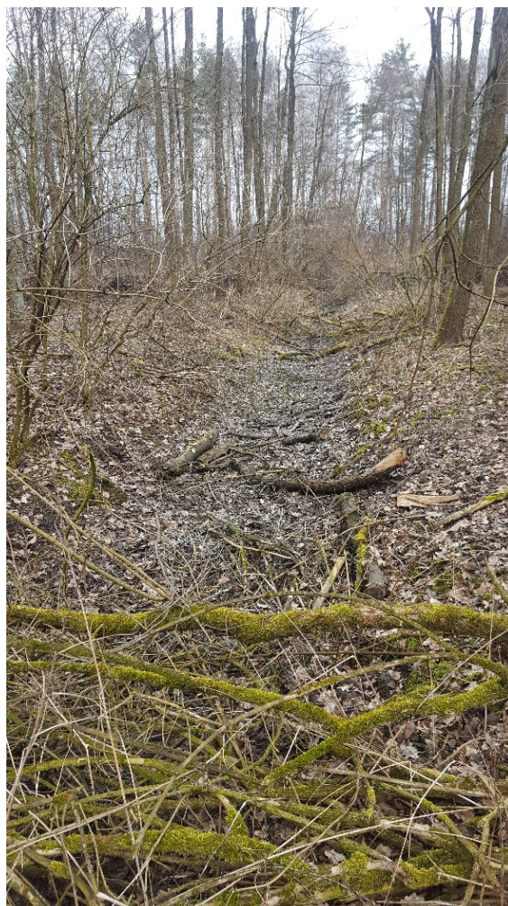
Rysunek 22. Fragment rowu melioracyjnego obrazujący ryzyko wystąpienia przeciwspadków
