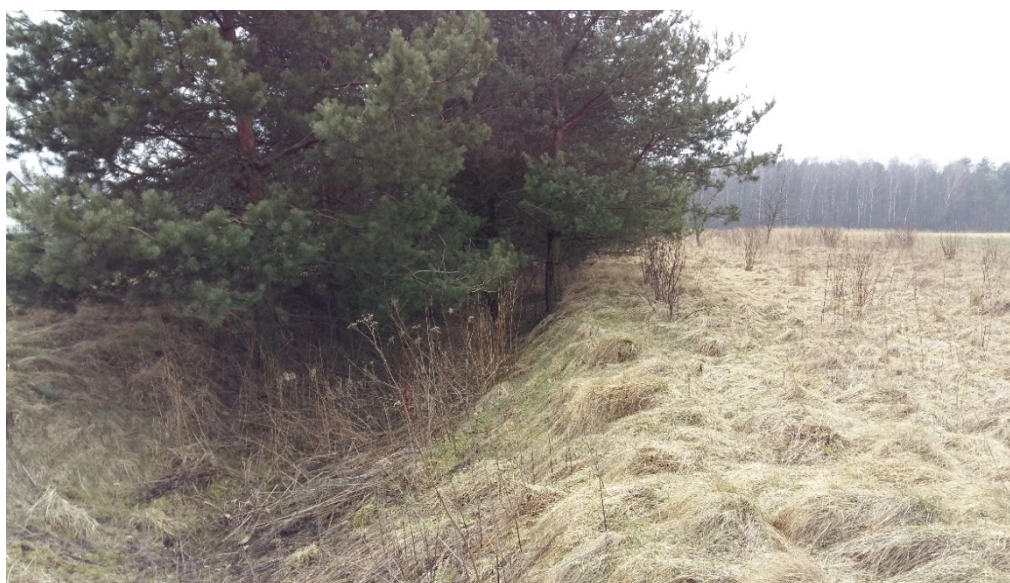
Rysunek 21. Zarośnięta część rowu melioracyjnego w rejonie ul. Kościelniaka.
