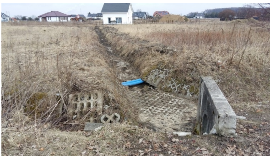
Rysunek 18. Częściowo odtworzone rowy i wlot przepustu powyżej ulicy Kościelniaka w Mysłowicach
