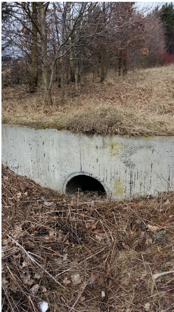
Rysunek 17. Wylot przepustu poniżej ulicy Kościelniaka w Mysłowicach
