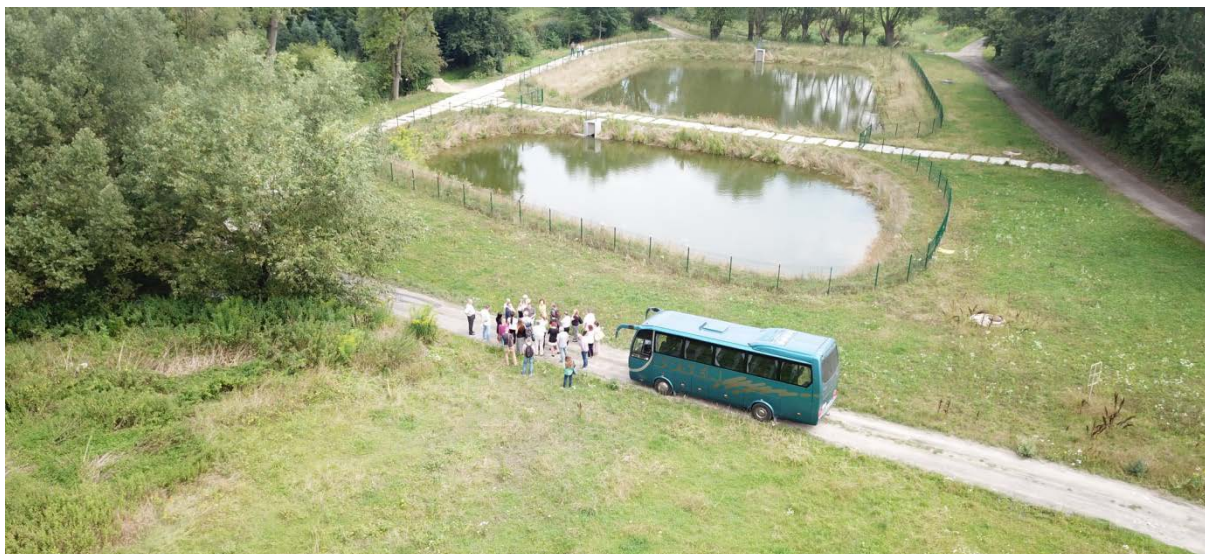
Rysunek 7. Widok na zbiorniki wód deszczowych ZR3
