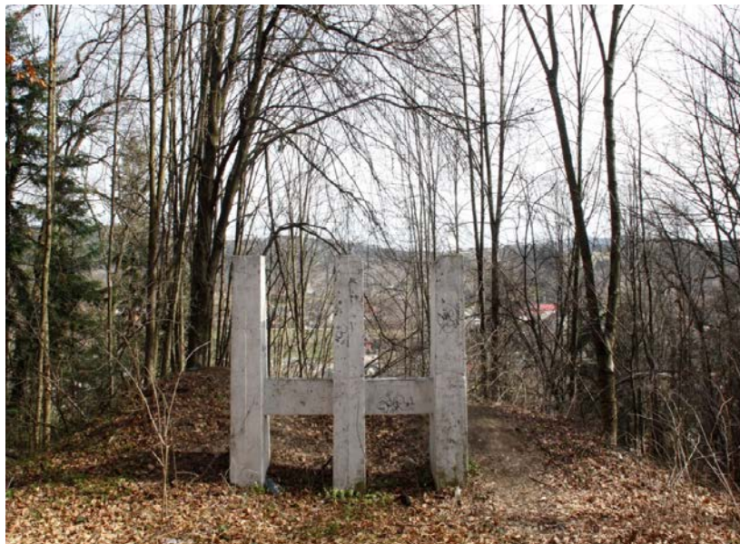
Rysunek 4. Las Falkowski – część północna – konstrukcja dawnej skoczni narciarskiej
